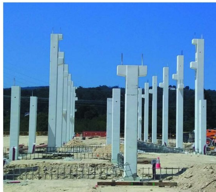
Detalle de pilar con panel colgado con guía de sujeción
