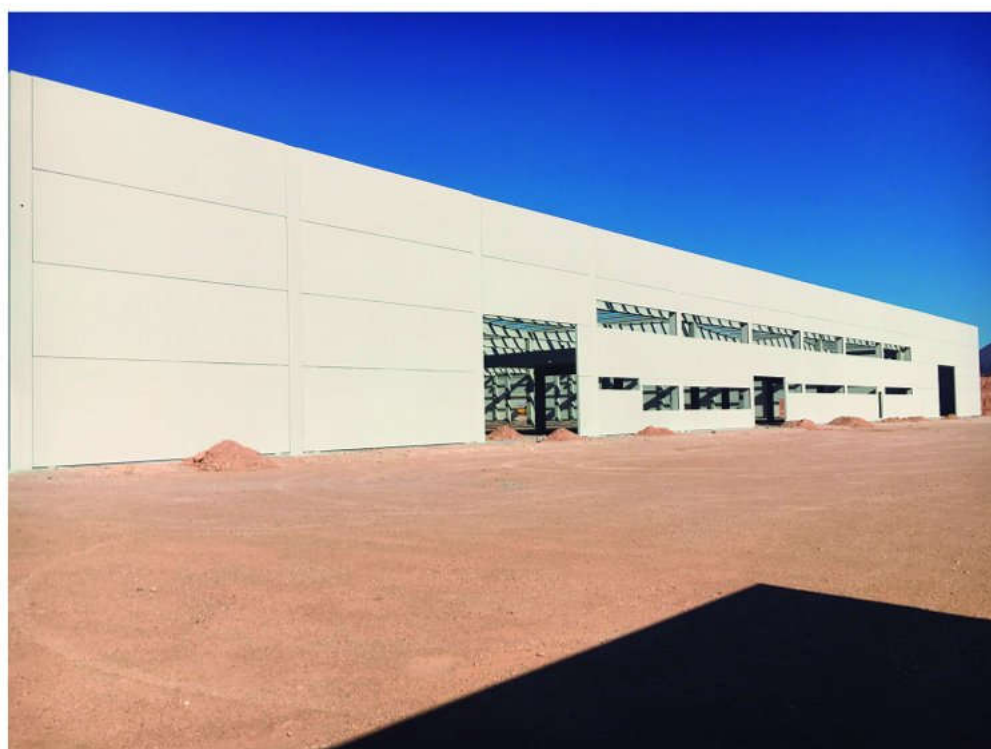
Nave industrial de pared de molde pintada
